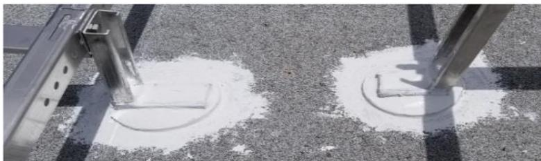
7. Haga una prueba para ver si todavía se empoza agua y saber si los trabajos realizados corrigieron las filtraciones si las hubiera. Tape todos los desagües y eche por lo menos 2 pulgadas de agua. Déjelo así por lo menos dos días. Si se presentan filtraciones se deberá seguir buscando detenidamente para encontrar tales penetraciones que estén generando filtraciones.
