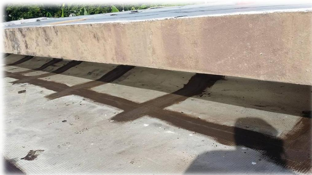
4. Los blíster (Bolsas sobre el sistema de aire o agua) pueden corregirse cortando la bolsa en forma de cruz con una cuchilla y después de sacar el aire o el agua, volverla a pegar con PA-550 sellando finalmente los cortes con Monolastic y malla.
