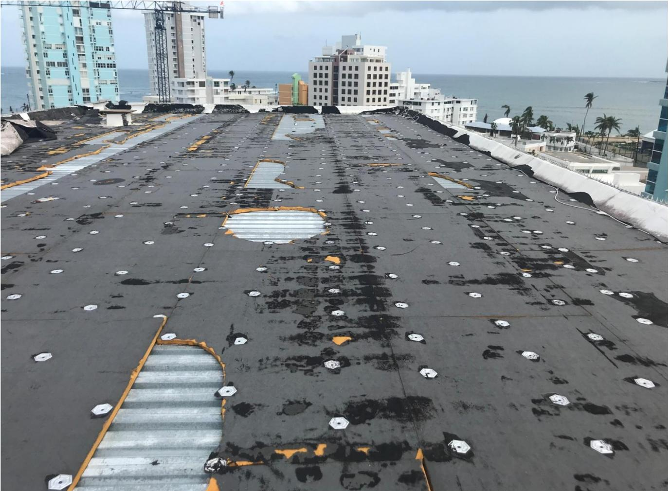
En esta foto mostramos un techo después de haber pasado el azote del huracán María. Aquí podemos apreciar que la membrana base fue soldada sobre una felpa asfáltica fijada a la aislación de techos con tornillos. Sin adherirla totalmente a la aislación.
